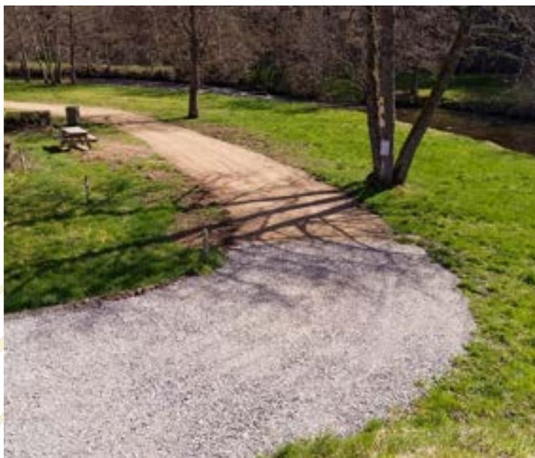
A l'automne dernier, le chemin de la plage a fait l'objet d'un nivellement sur 160 mètres. L'entreprise Besançon s'est chargée d'effacer de nombreuses pierres, souches et
